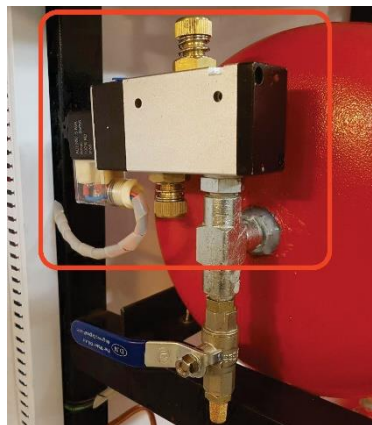
شکل ۸-۳ شیر برقی تخلیه هوا
